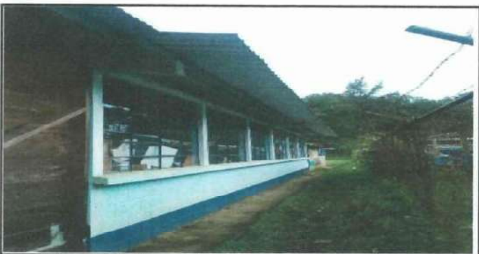
Foto 5: Urge la instalación de canales en este lado del techado para evitar la filtración e la lluvia. También necesita mantenimiento la banqueta detrás de las aulas. Tambien las puertas principales necesitan reparaciones.
